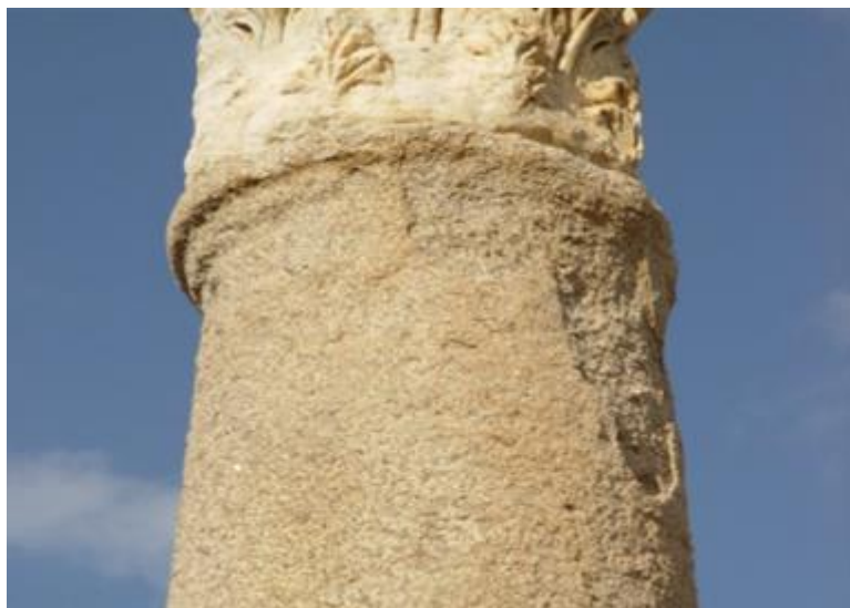
شكل (2. 20) تجوية المادة اللاحمة ومن ثم الفلسبار في أحد الأعمدة الجرانيتية.
