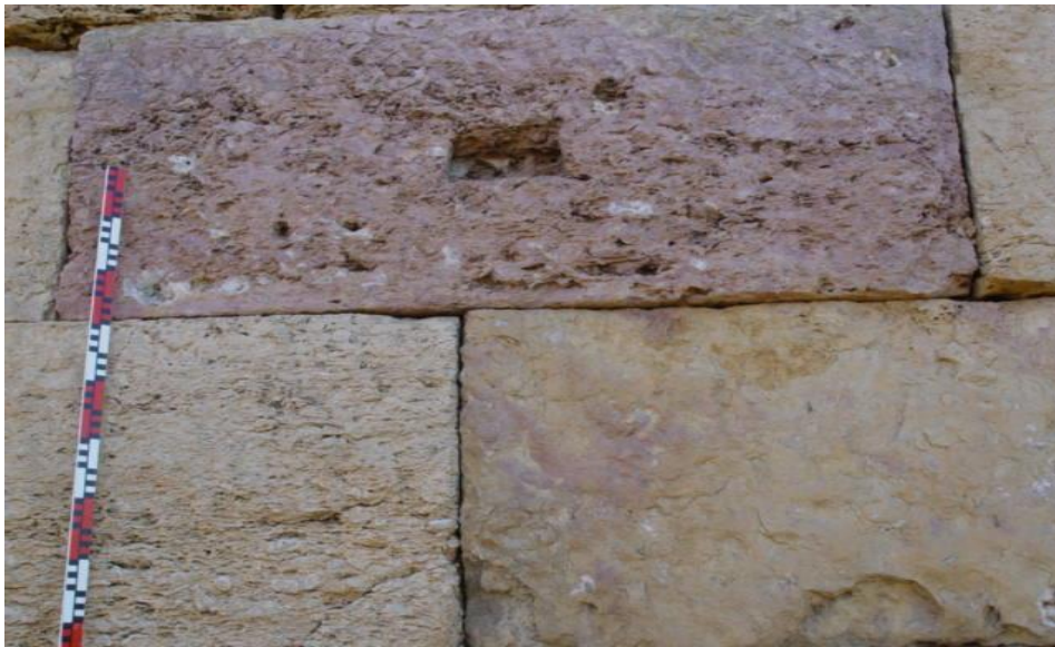
شكل (2. 22) تآكسد بعض الكتل الصخرية .
