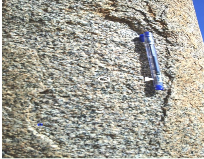
شكل (2. 2) عمود من الجرانيت يظهر حالة التقشر.
