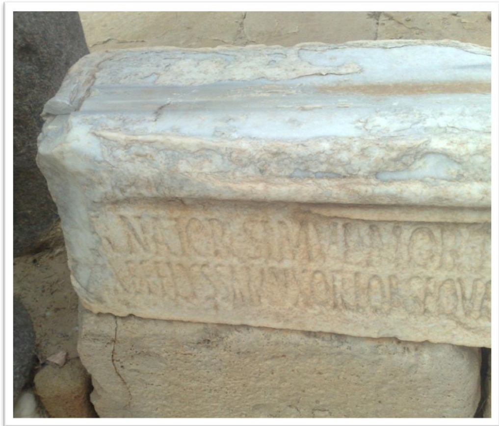
ملحق ( 1 ) صورة للفشور الجبسية المتكونة على الرخام تحت تأثير التلوث بثاني أكسيد الكبريت
