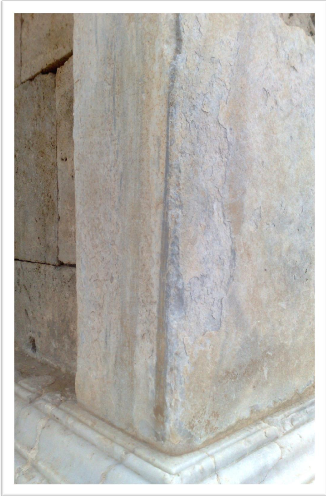
ملحق (2) صورة لتآكل القشور الجبسية المتكونة على عمود من الرخام تحت تأثير التلوث بثاني أكسيد الكبريت
