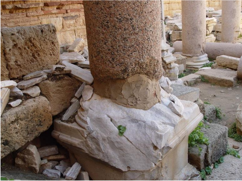
الشكل (2. 31) بعض مواقع الترميم بالأسمنت .
