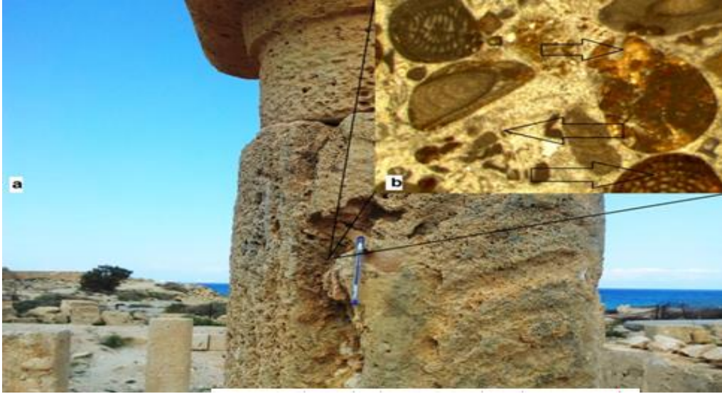
شكل (12.3) a عمود من الحجر الجيري b صورة المجهر المستقطب.
