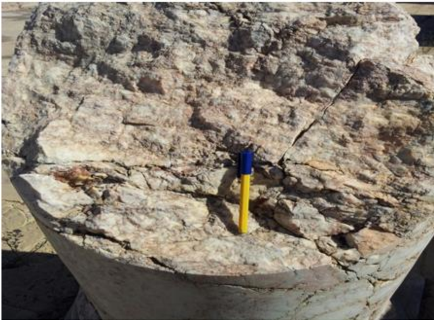
شكل (2. 14) شقوق الأعمدة الرخامية والتي تنهار بسبب النمو البلوري للمياه.
